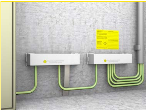
Abb. 2: Abgeschlossene Erdung der Fassadenflächen mit Kennzeichnungen
