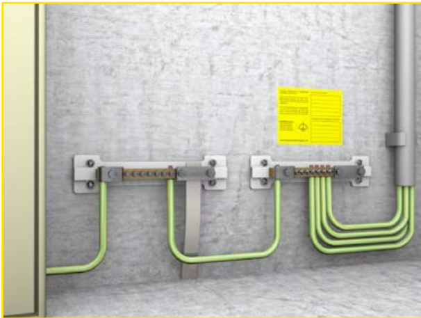
Abb. 1: Anschluss des Potentialausgleichsleiters an Potentialausgleichschiene mit Kennzeichnung.
