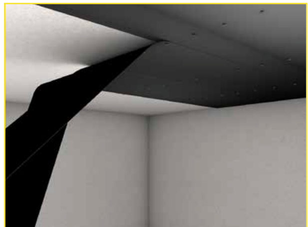
Abb.18: Provisorische Befestigung der Bahnen
