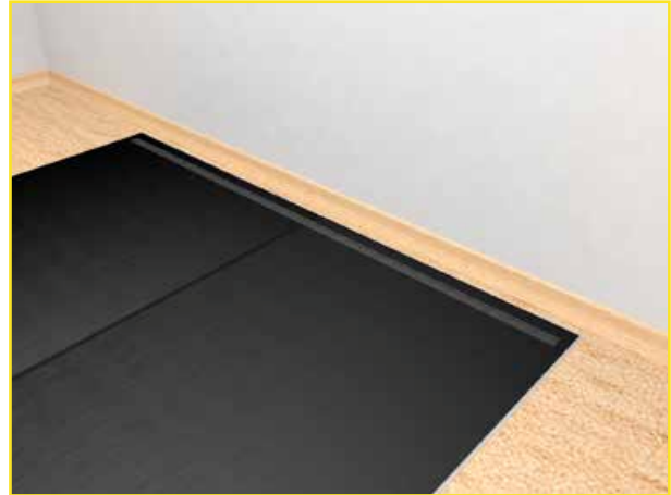
Abb.23: Erdungsband verkleben (nur bei 2 oder mehr Bahnen)
