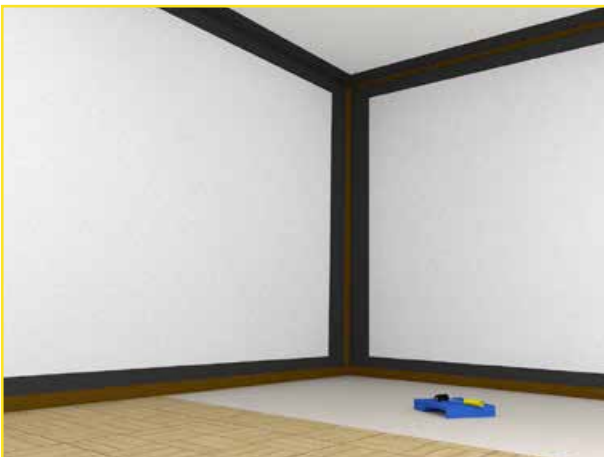
Abb.5: Erstes Streichen der Raumecken, Fensterlaibungen und der vom Heizkörper verdeckten Flächen.
