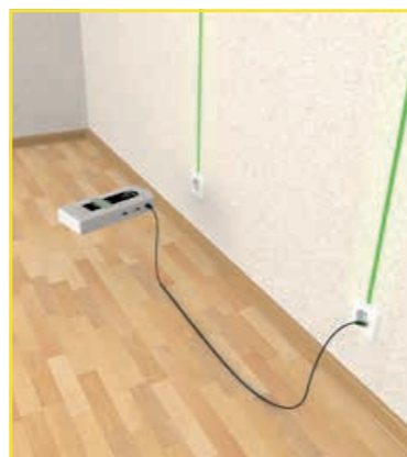
Messung während und nach nach Schirmung und erfolgter Erdung der Fläche oder Kabel.
