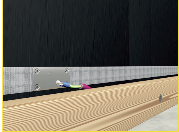
Abb.17: Anbringen des Erdungsbandes AEB 3,0 - Erdung mit EGP
